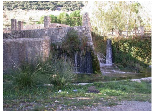
Salida en muro del estanque (C. Martín Montañés)
